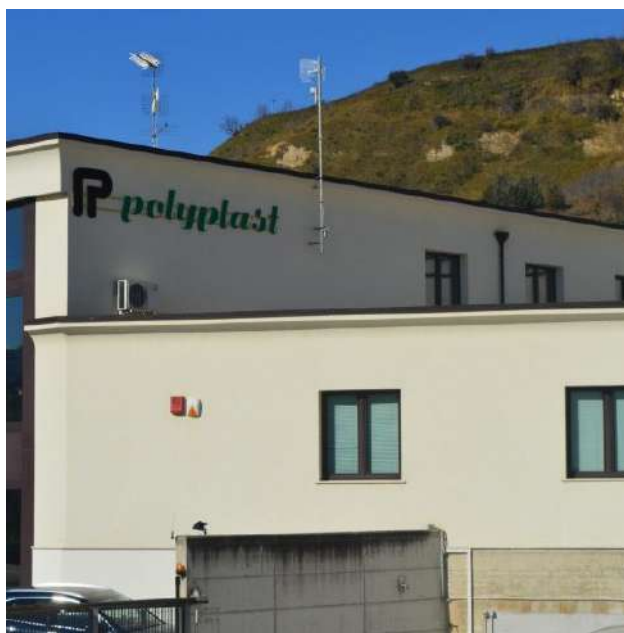
Figura 1 Vista dello stabilimento
